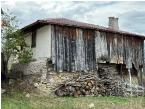
b) Kuzey ve doğu cephesi
