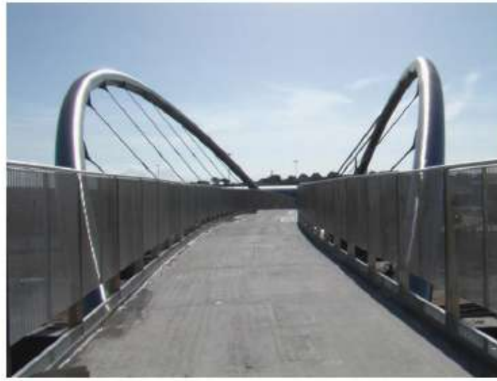
Şekil 3.2. Holyhead, Birleşik Krallık'taki Celtic Gateway yaya köprüsü
