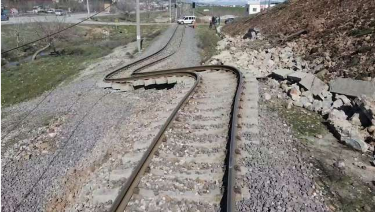
Şekil 1 Kahramanmaraş Türkoğlu Şekeroba Mahallesinden geçen demiryolu
