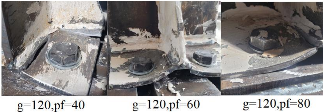
Şekil 4. Deney numunelerinin göçme durumları
