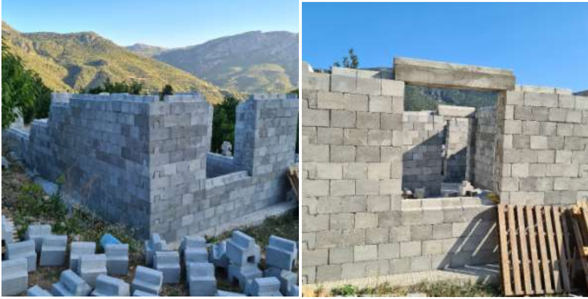
Şekil 6. Pencere için lego beton lento bağlantısı
