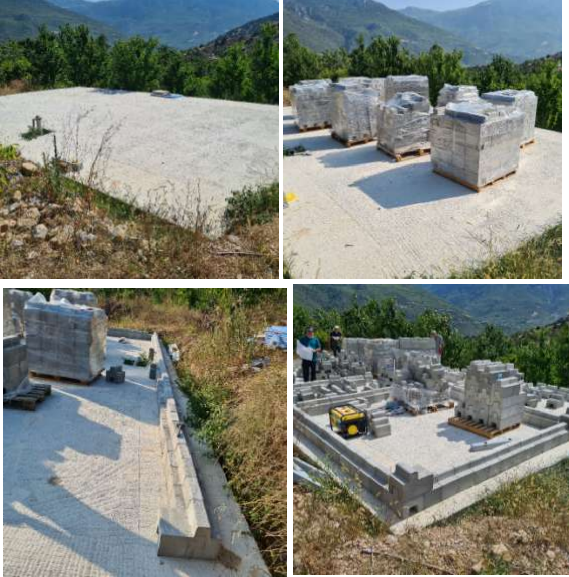
Şekil 4. Lego betonların tesviye betonu üstüne kurulumu
