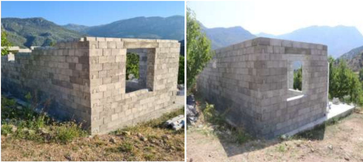
Şekil 7. Modüler lego beton ile tamamlanmış yığma ev örneği
