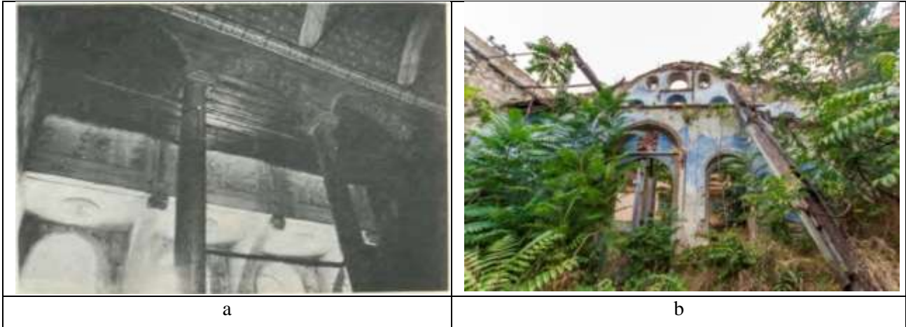
Şekil 11. a) Aydınpınar kilisesi 1983 yılı kat planı (Ötüken vd., 1983) b) 2014 yılı kat planı (Yıldız, 2018) c) Güney nef, ahşap sütunlar ve galerinin görüntüsü (1983 yılı) (Ötüken vd., 1983) d) Devrilen ahşap sütun ve yok olan galeri katı izi (Url 1)
