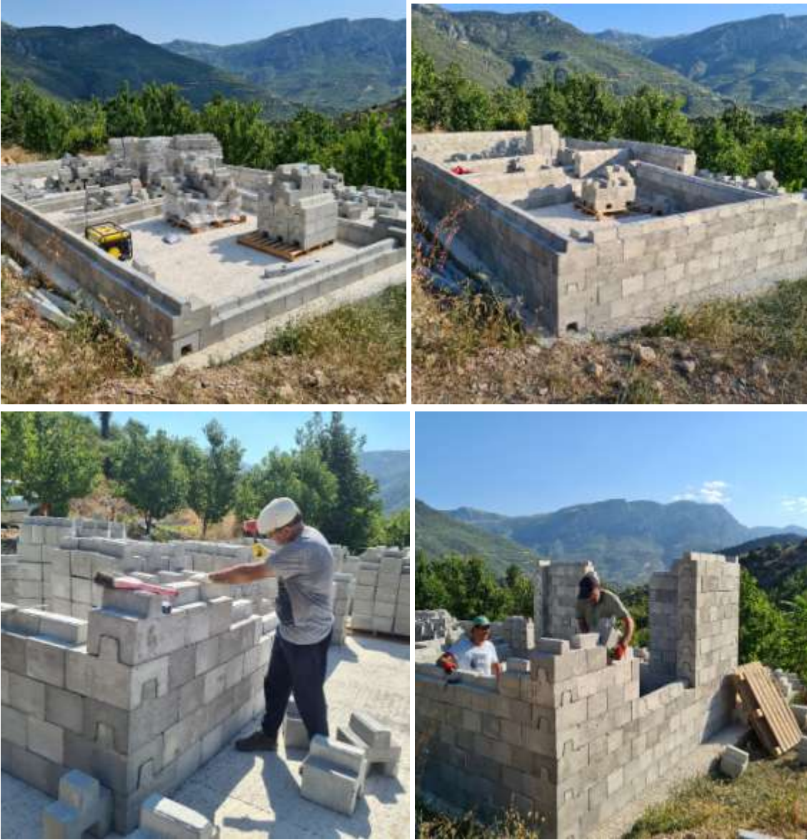
Şekil 5. Modüler lego betonların kurulumu
