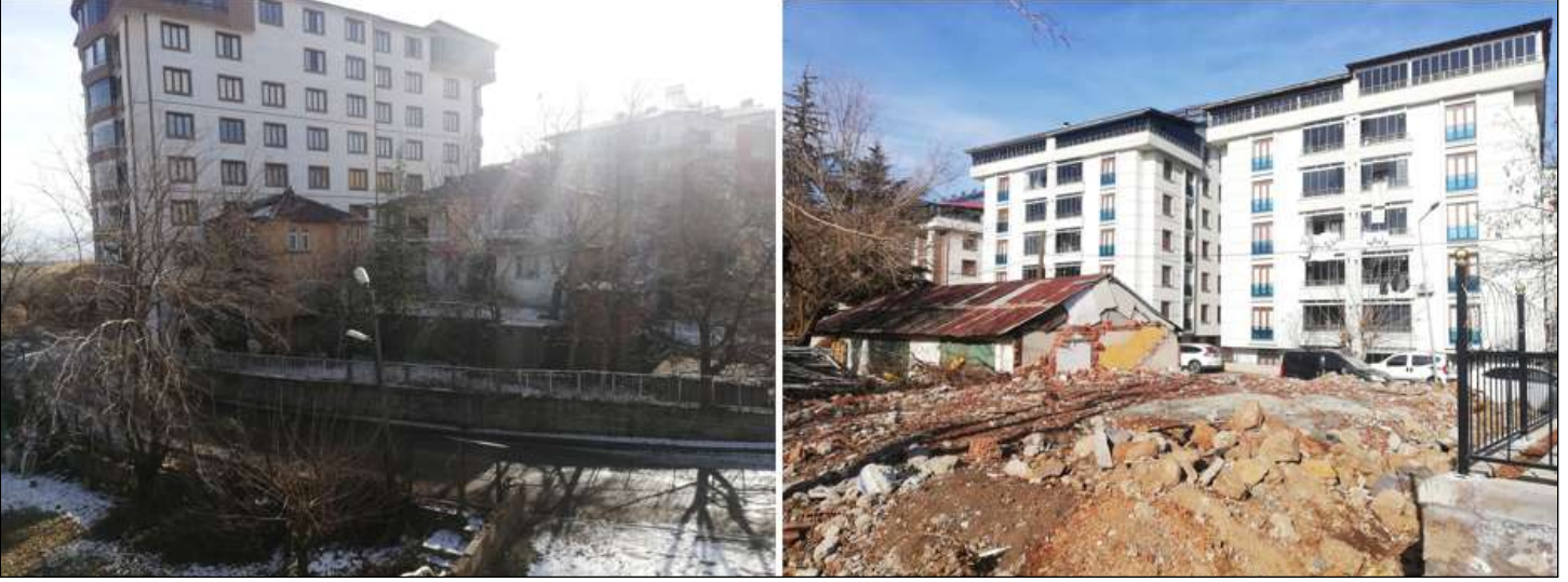
Foto 1 ve Foto 2. Bingöl’de deprem sonrası değişen mahalle yapısına örnekler
