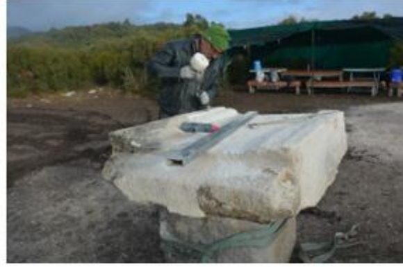
Şekil 32: Parapet Tümleme ve İşleme Çalışmaları.
