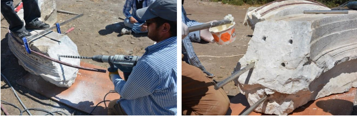
Şekil 18–19: Arşitrav Onarımları/Donatı Yerleştirme.
