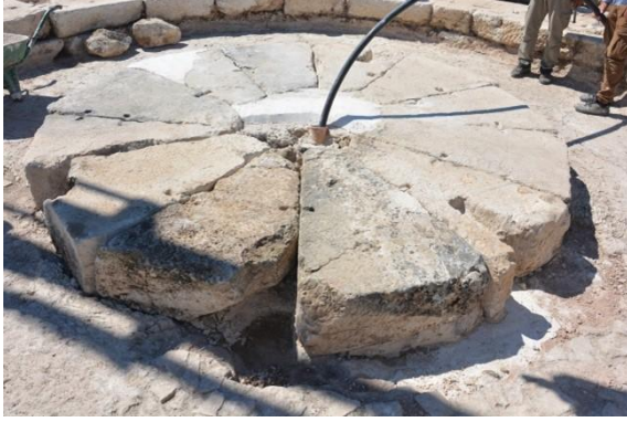
Şekil 9: Temel Blokları, Su Hattı Çekme.
