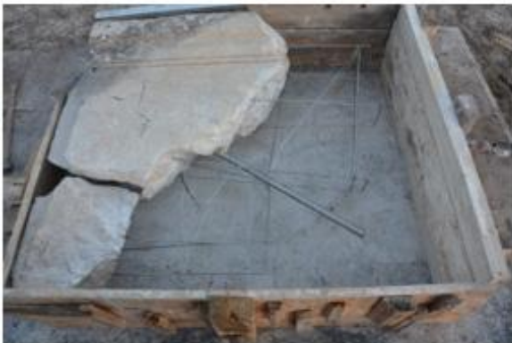
Şekil 32: Parapet Tümleme ve İşleme Çalışmaları.
