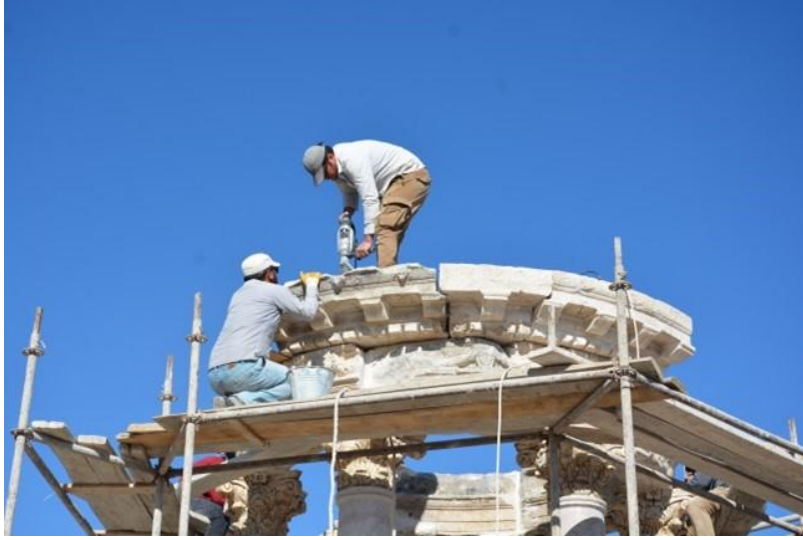
Şekil 26: Kornişlerin Montajı.
