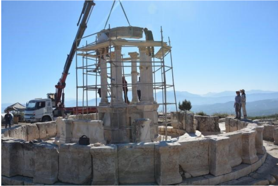
Şekil 23: Arşitrav Montajı.
