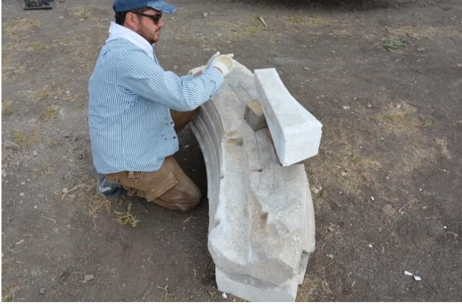
Şekil 22: İmitasyon Onarım Bloğu Montajı.
