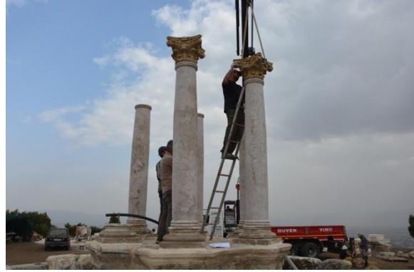
Şekil 16–17: Taşıyıcı Elemanların Montajı
