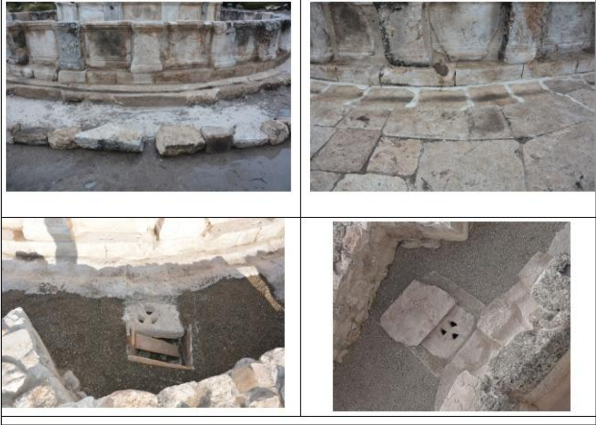
Şekil 35: Tahliye Kanalı Onarımları ve Rögar Kapağı.
