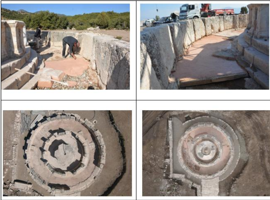
Şekil 34: Havuz Tabanları Tümleme Çalışmaları.
