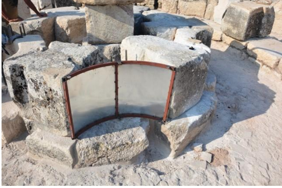
Şekil 11: Kule, Alt Sıra, Yerleştirme ve Tümleme.
