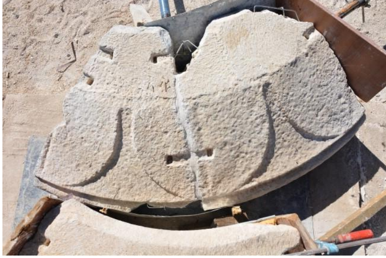
Şekil 27: Çatı Blokları Birleştirme ve Tümleme İşlemi.
