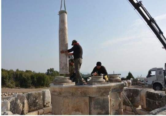
Şekil 16–17: Taşıyıcı Elemanların Montajı
