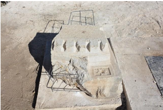
Şekil 24–25: Korniş Bloklarının Onarım, Tümleme ve İşlenmesi.
