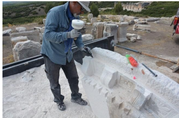
Şekil 24–25: Korniş Bloklarının Onarım, Tümleme ve İşlenmesi.
