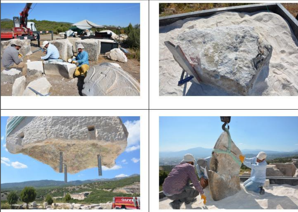
Şekil 28: Çatı Blokları, Birleştirme ve Onarım Çalışmaları.
