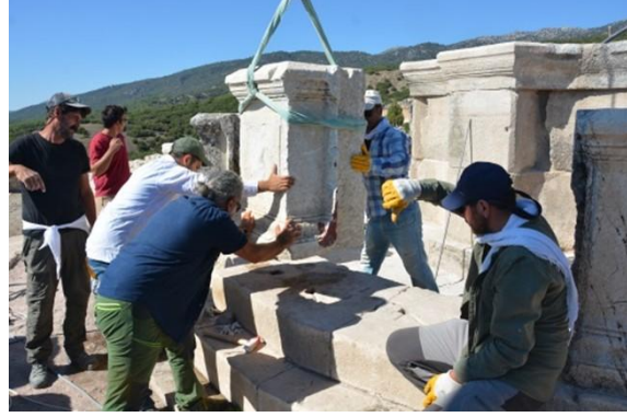
Şekil 30–31: Merdiven ve Postamentlerde Onarım ve Yerleştirme Çalışmaları.
