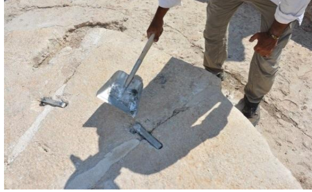
Şekil 10: Kenetle Birleştirme.
