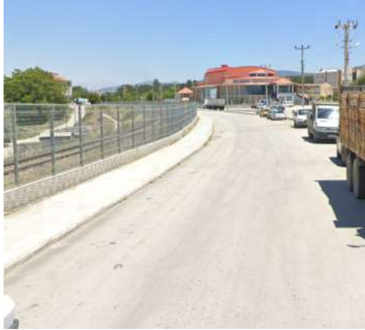
Şekil 4. Özgür Mahallesi Bisiklet Yolu ve Sorunlu Alanları
