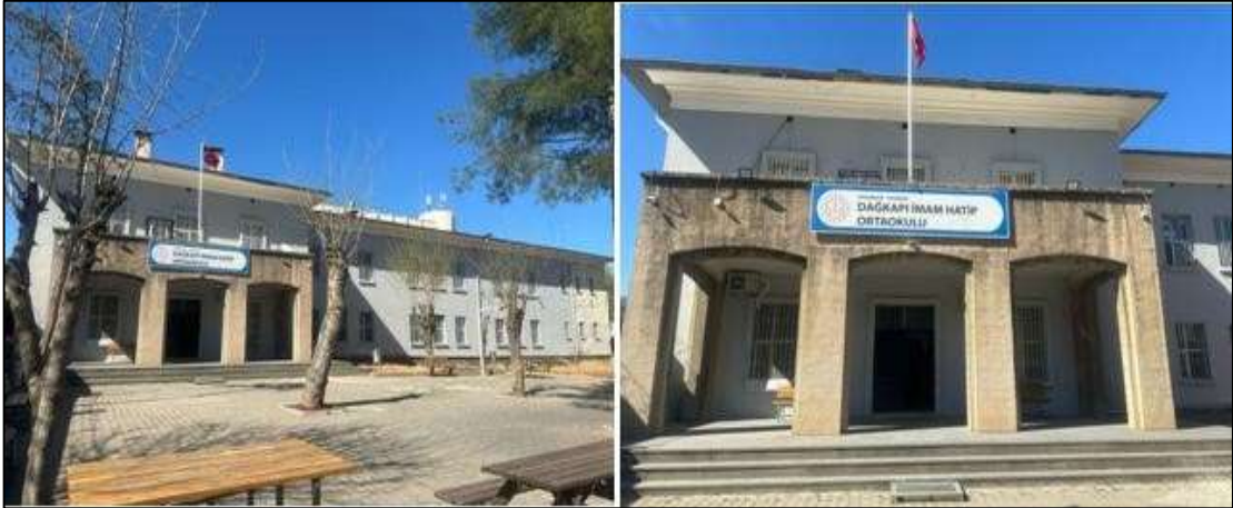
Şekil 17. Dağkapı İmam Hatip Ortaokulu Dış Cephe
