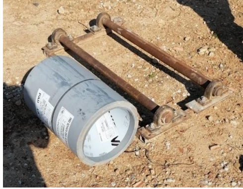
Şekil 8: Şantiye ortamına rulo halinde gelen metal çatı kaplama malzemesi.
