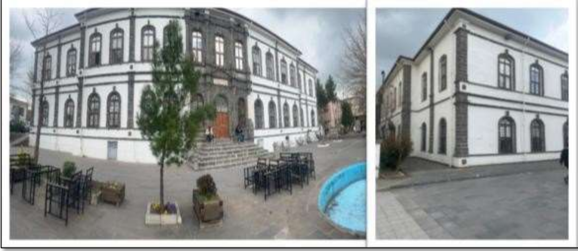
Şekil 5. Diyarbakır İdadi Mektebi Dış Cephe
