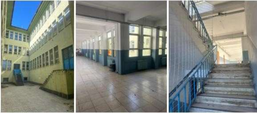
Şekil 29. Hasanpaşa Ortaokulu Dış ve İç Mekanlar
