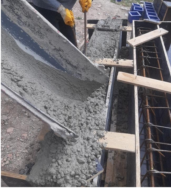
Şekil 4. Numunelerin hazırlanması ve Kürü işlemleri
