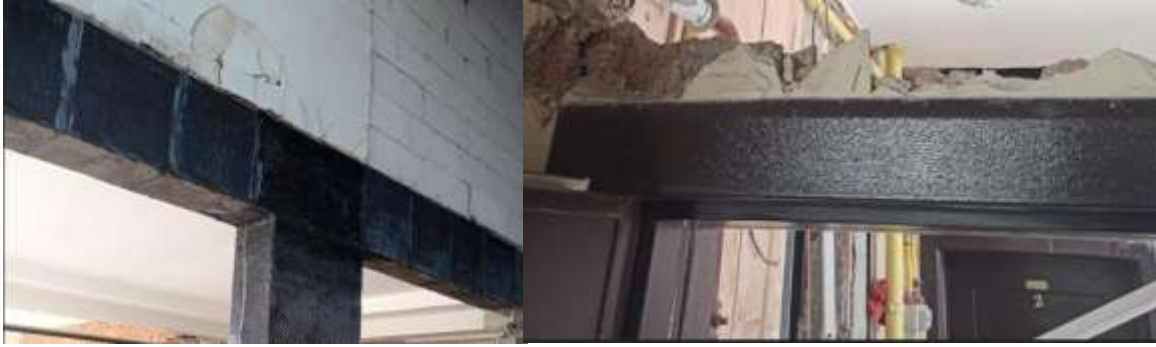
Şekil 2. BA kirişlerde lifli polimer kullanılarak yapılan güçlendirme örnekleri
