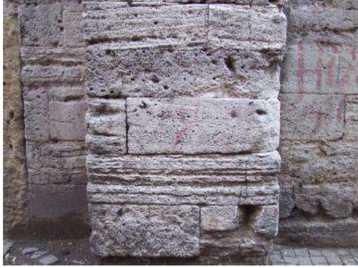
Şekil 2. Sıfır derz taş duvar (Kara, 2009)
