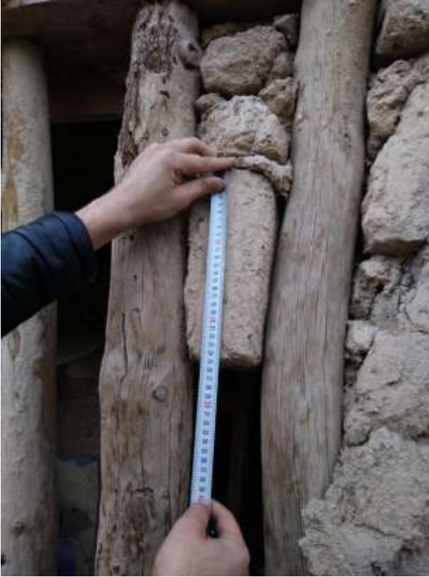
Şekil 7. Ahşap Karkas ev ana kerpiç boyutları (solda) ve geleneksel kerpiç üretimi (sağda).
