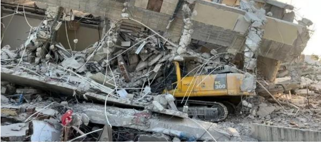
Şekil 2. İş Makinesinin Üzerine Yıkılan Bir Bina
