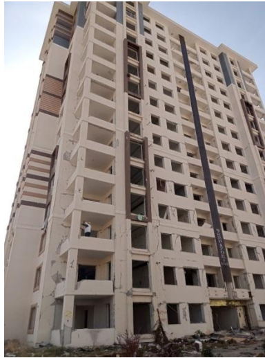
Şekil 1. Yıkımı Gerçekleştirilen Apartmanın Görünümü
