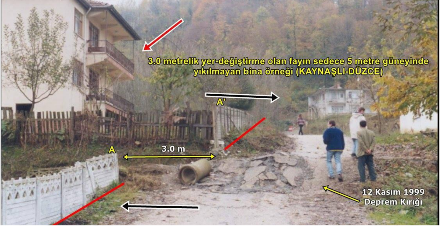
Şekil 4. 1999 Kaynaşlı depreminde hasar almamış bir yapı ve yakınında geçen fayın 3 metrelik yer değiştirmesi
