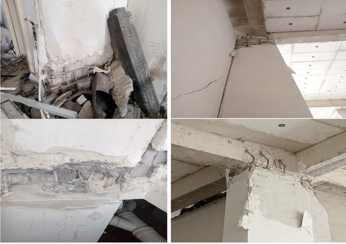
Şekil 2. Ağır hasarlı olmasına sebep olan bazı görüntüler
