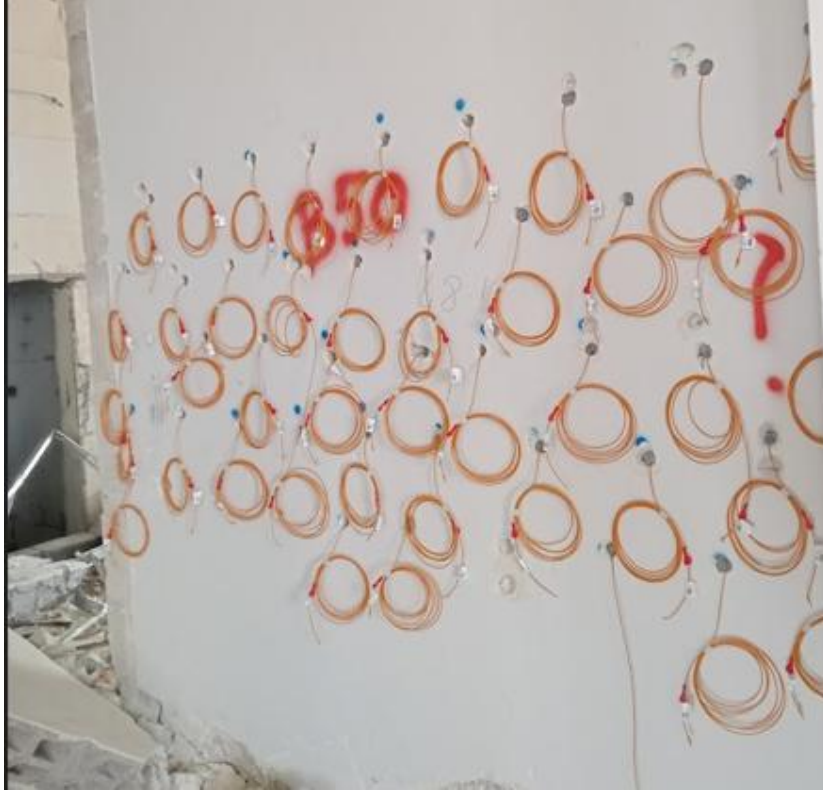
Şekil 4. Patlatmaya Hazır Hale Getirilen Delikler
