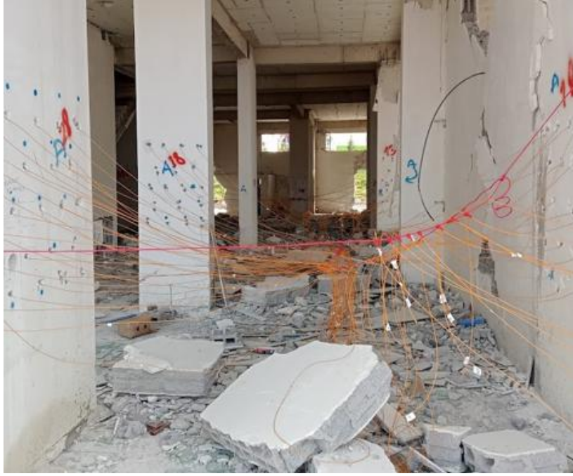
Şekil 5. Patlatılmaya Hazır Hale Getirilmiş Kolonlar
