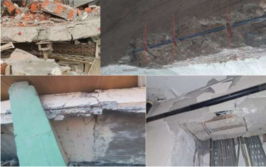
Şekil 4. BA kirişlerde yetersiz enine donatı örnekleri
