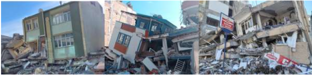
Şekil 3. Depremlerin BA yapılar üzerindeki etki örnekleri
