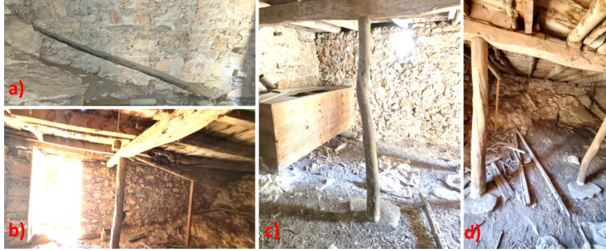
Şekil 10. a) Kuzey cephesinin görünümü, b) Güney cephesinin görünümü, c) Doğu cephesinin görünümü, d) Batı cephesinin görünümü (Kişisel arşiv, 2024)
