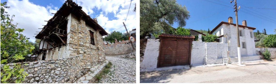
Şekil 4. Bozüyük'te yüksek bahçe duvarlı konut örnekleri (Kişisel arşiv, 2024)
