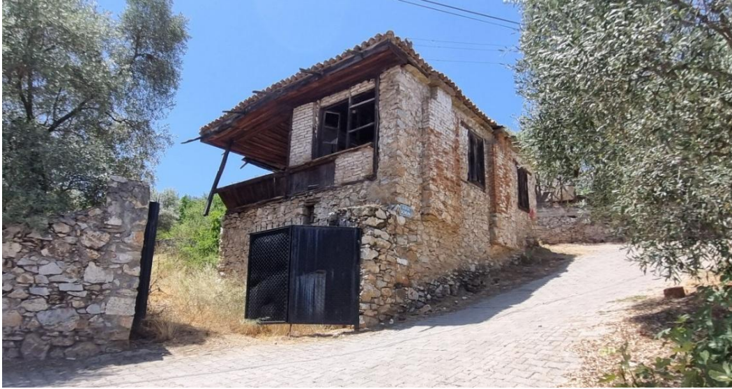
Şekil 7. 1376 parsel konut ve bahçe sınırlarının görünümü (Kişisel arşiv, 2024)
