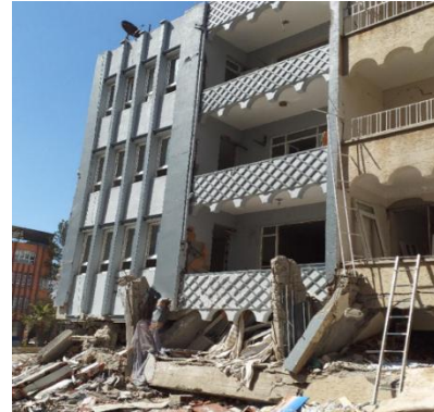
Şekil 3. İncelenen BA binaların deprem öncesi ve sonrası durumları
