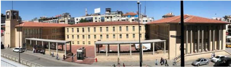
Görsel 19. Gaziantep Hükümet Konağı ön cephe (Sacır, 2018)
