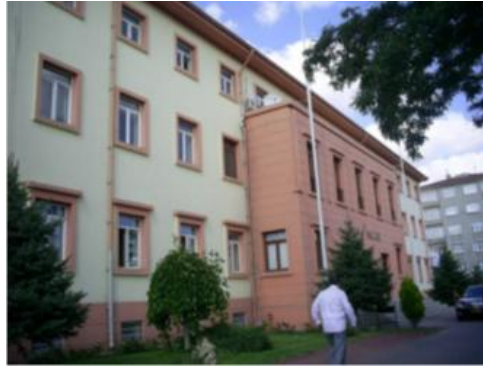
Görsel 12. Yozgat Eski Hükümet Konağı ön cephe (Koç Ünlüsoy, 2010)
