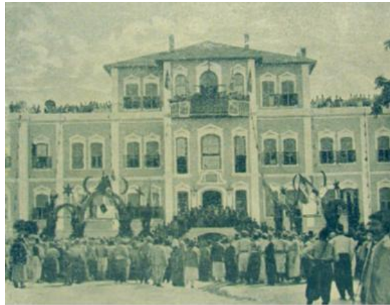
Görsel 4. Adana Hükümet Konağı (Umar, Can; 2019)
