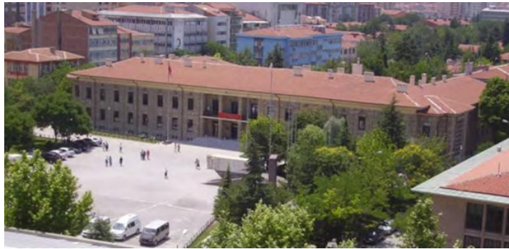
Görsel 17. Eskişehir Hükümet Konağı ön cephe (Koca, Karasözen; 2010).
