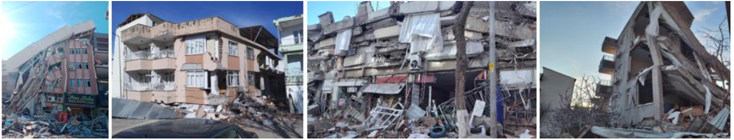
Şekil 1. Farklı düzeylerde hasar almış BA yapı örnekleri
