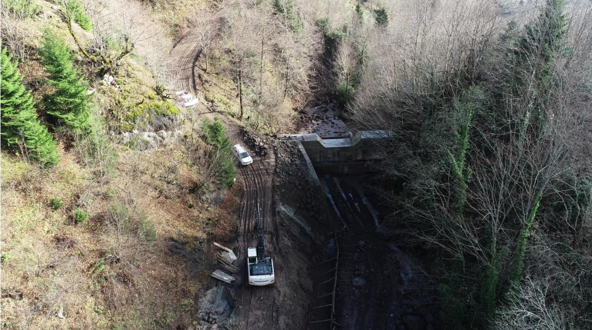
Şekil 11. Akkaya Deresi menba klasik tersip bendi inşaatı (foto: Okan Yonkuç)
