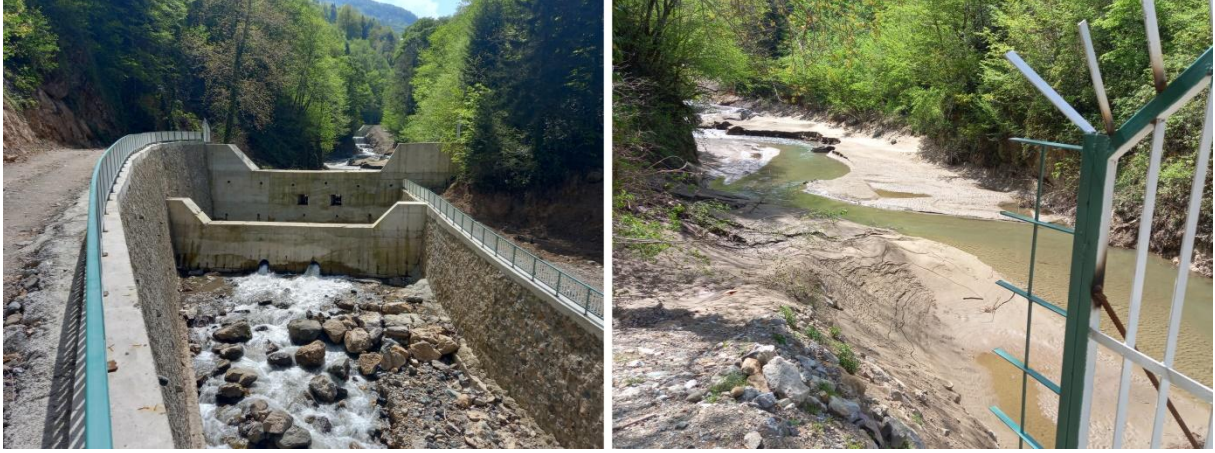
Şekil 7. Dereli Deresi'ndeki 1 No.lu tersip bendi ve arkasında ince taneli sediment birikimi (foto: A.Apaydın, 24 Nisan 2022)
