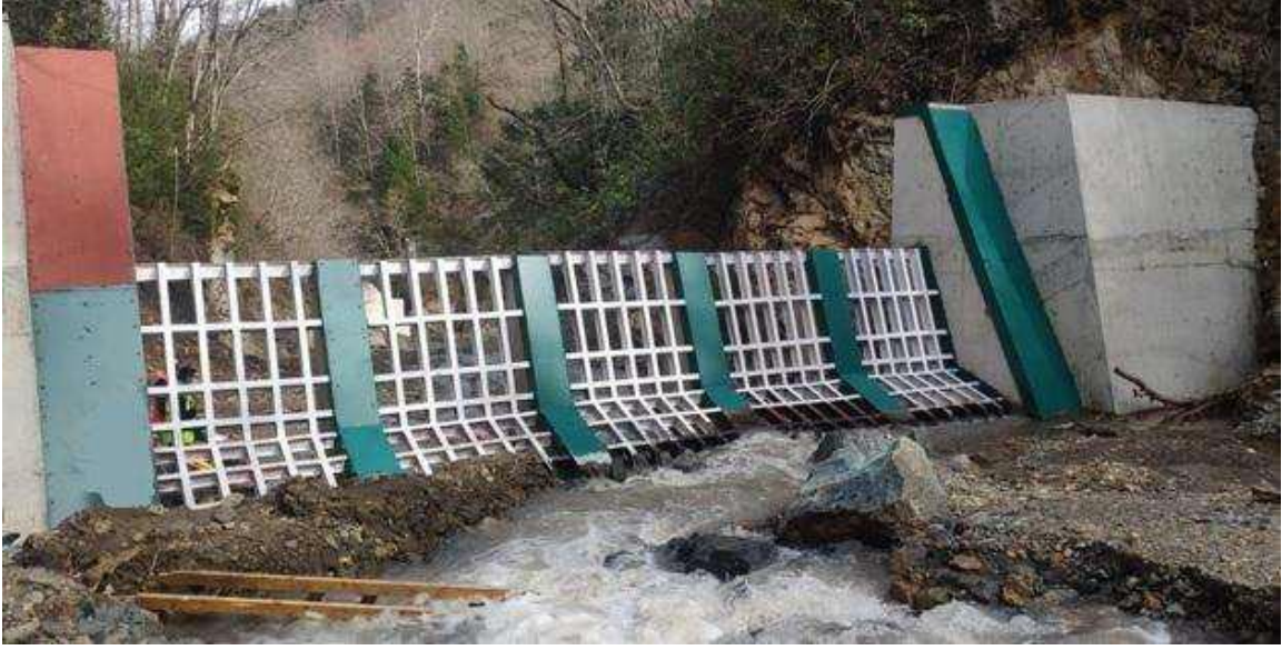
Şekil 8. Dereli Deresi üzerindeki 1 No.lu geçirgen tersip bendi (foto: Okan Yonkuç)
