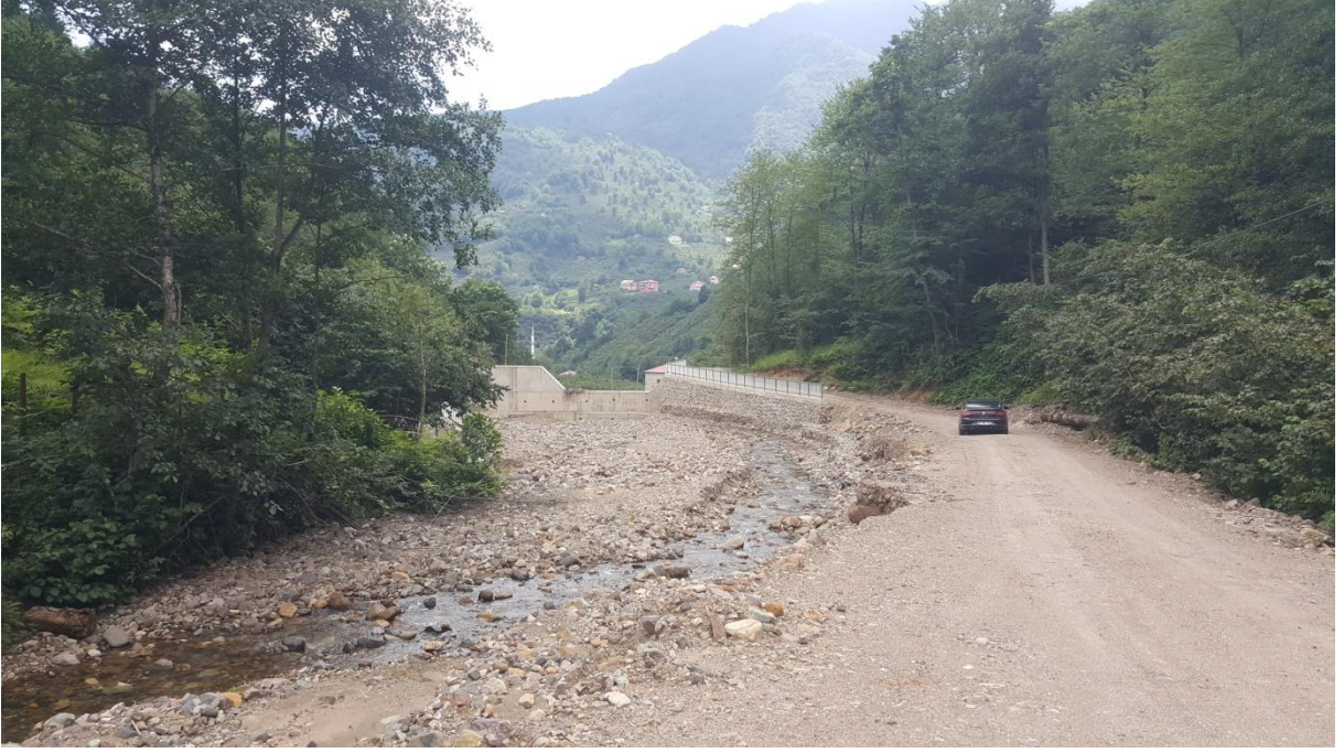
Şekil 14. Akkaya Deresi mansap klasik tersip bendi (foto: Okan Yonkuç)
