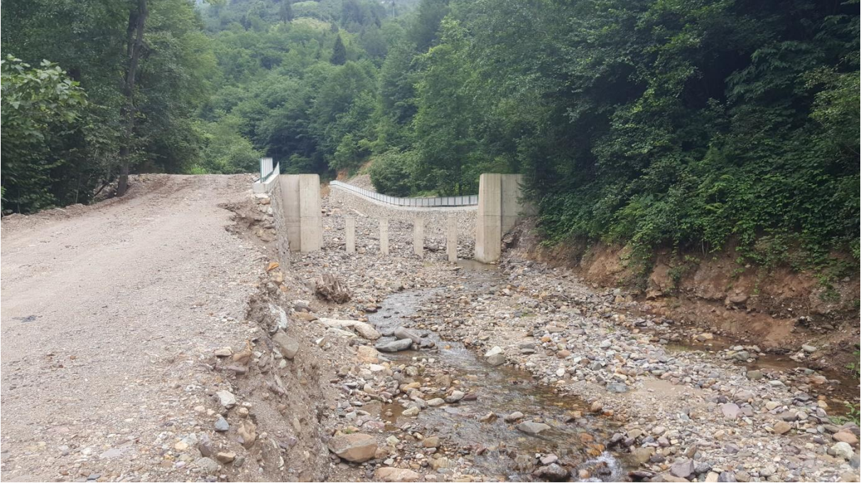
Şekil 13. Akkaya Deresi mansap geçirgen tersip bendi (foto: Okan Yonkuç)
