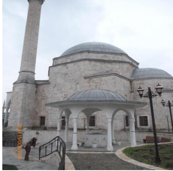
Resim 3: Sinan Paşa Camii Dış Cephe Kubbe, Kasnak, Mihrap Önü Çıkıntısı ve Pencere Ayrıntıları
