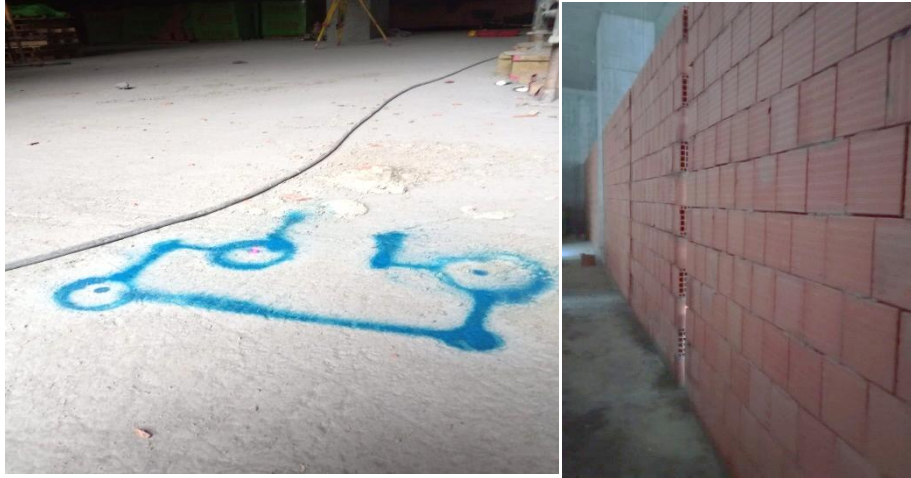
Şekil 4: Tuğla duvar aplikasyon noktaları ve duvarın bitmiş hali.
