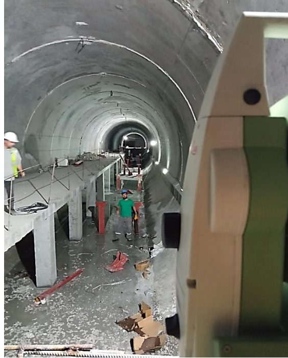
Şekil 13: Yürüyen bandın çelik destek yerleri.
