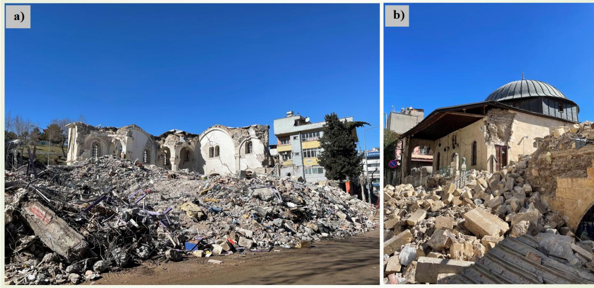
Şekil 4. Adıyaman'da çöken ve hasar alan yığma cami ve minare örnekleri
