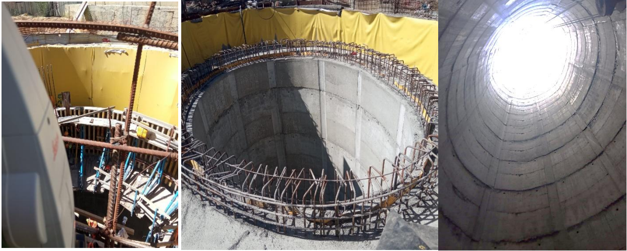
Şekil 7: Şaft perdesi yapılırken değişik açılardan görünüm.
