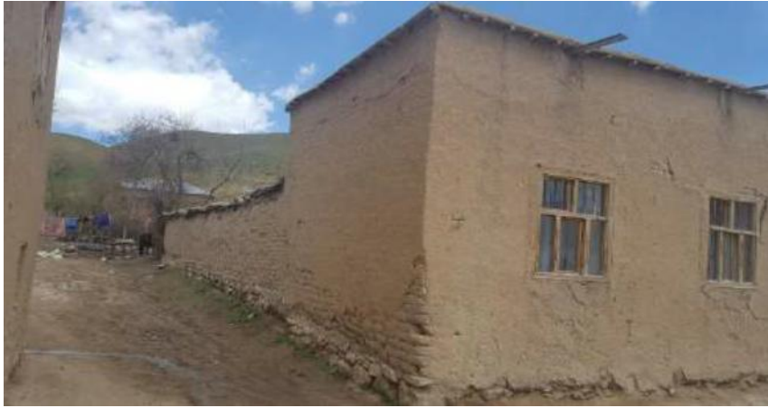
Şekil 11: Ahşap hatıllı düz toprak damlı Başkale kırsal konutlarından bir örnek
