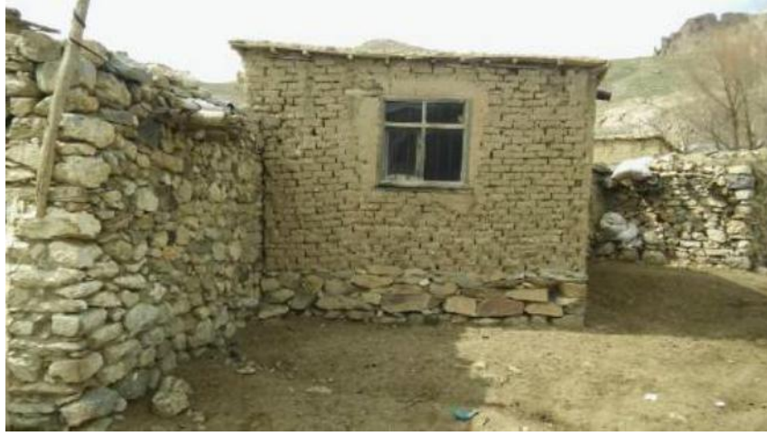
Şekil 23: Başkale kırsal konutlarında taş ve kerpiç malzeme kullanımı
