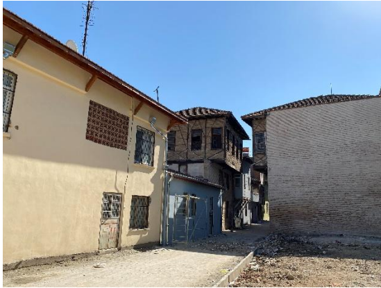
Şekil 2.19. 26012 Sokak Sağlıklaştırma Çalışmaları
