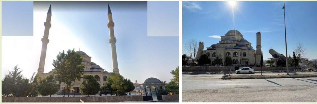
Şekil 7. Kahramanmaraş'ta yıkılan betonarme minareler
