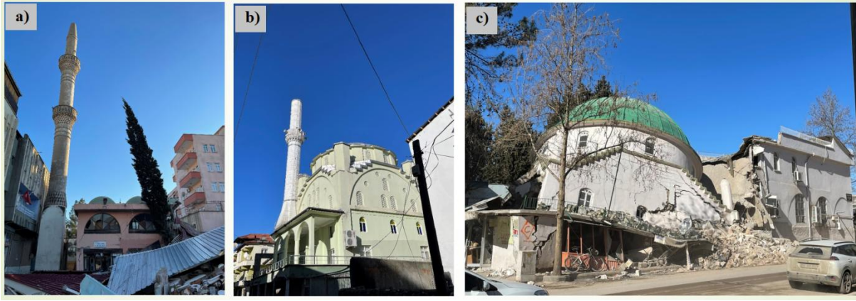
Şekil 5. Adıyaman’da hasar alan ve çöken betonarme minare örnekleri
