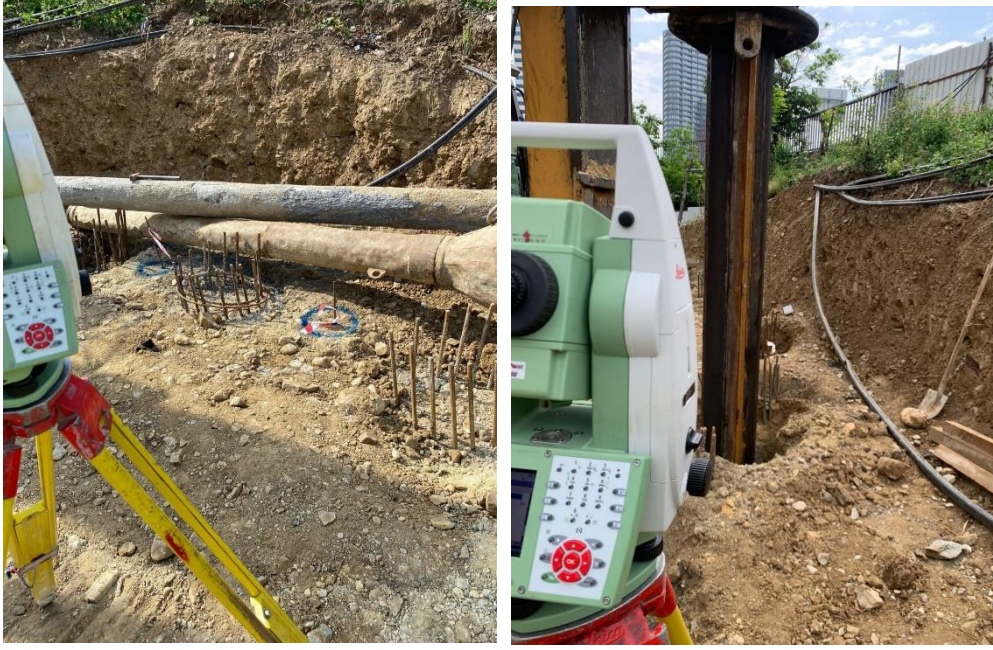
Şekil 6: Fore kazıkları aplikasyonu ve fore kazıkların rok makinasıyla kazısı yapılışı.
