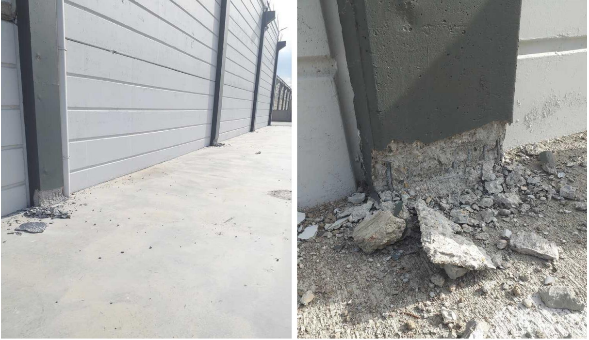
Şekil 8. Kolon tabanında oluşturulan plastik mafsallar
