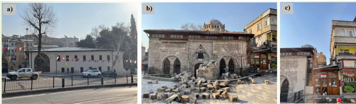
Şekil 6. Kahramanmaraş’ta yıkılan yığma minare örnekleri
