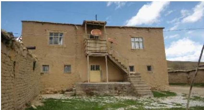
Şekil 12: Başkale kırsal konutlarından iki katlı yapı örneği
