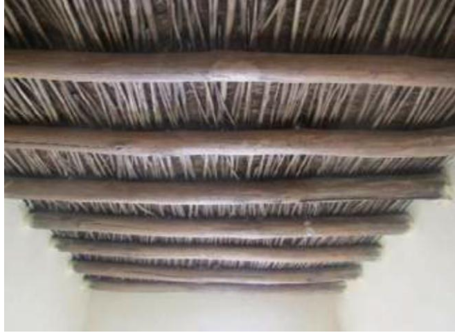
Şekil 24: Başkale Kırsal Konutunda Ahşabın Üst Örtüde Taşıyıcı Olarak Kullanımı
