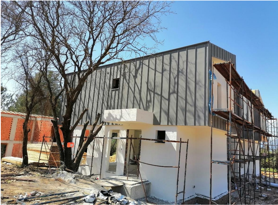
Şekil 13: Muğla ili Gökova ilçesi Yağmur Evlerine ait yapı.
