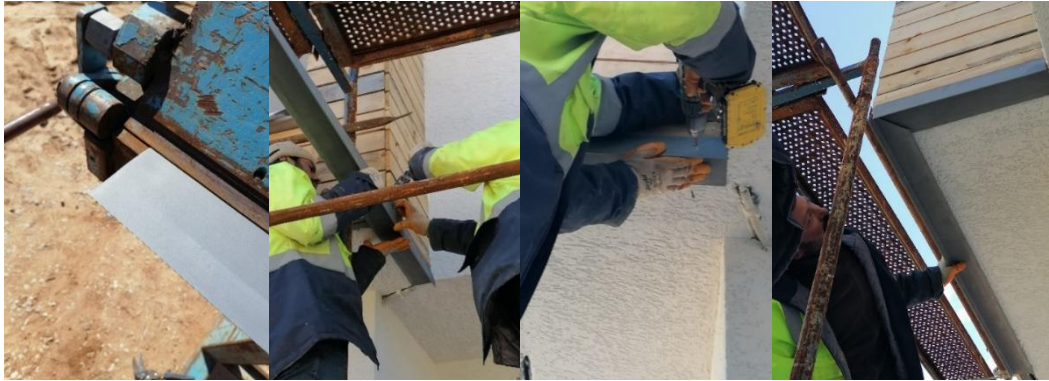
Şekil 9: Yaka profillerinin bükümünün ve montajının yapılması.
