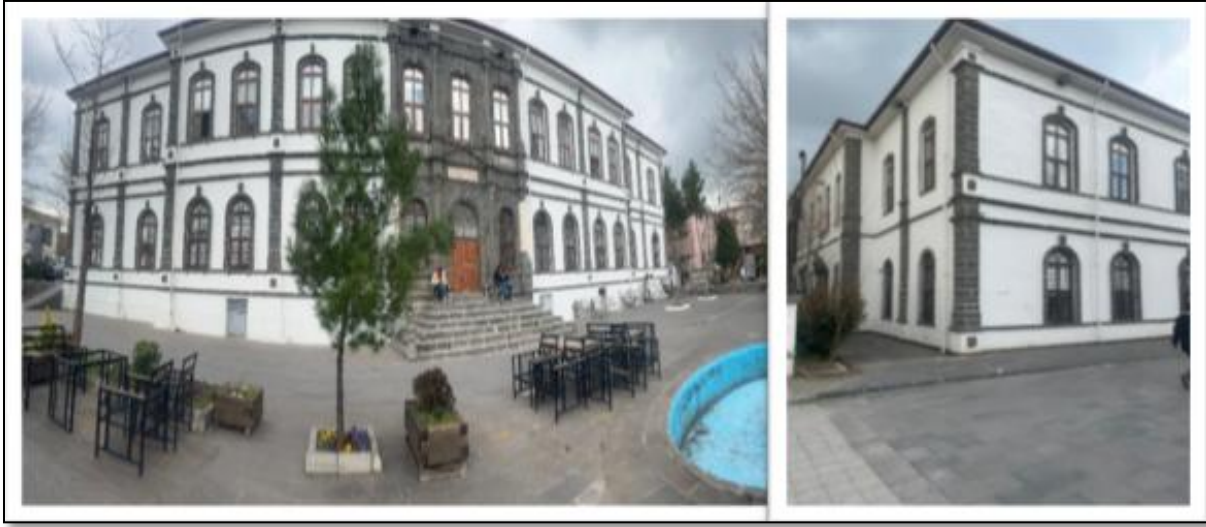
Şekil 5. Diyarbakır İdadi Mektebi Dış Cephe
