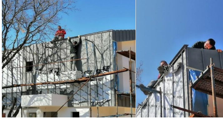
Şekil 12: Metal levhaların çatıya montajının sağlanması için çatı birleşim aksesuar montajının yapılması.
