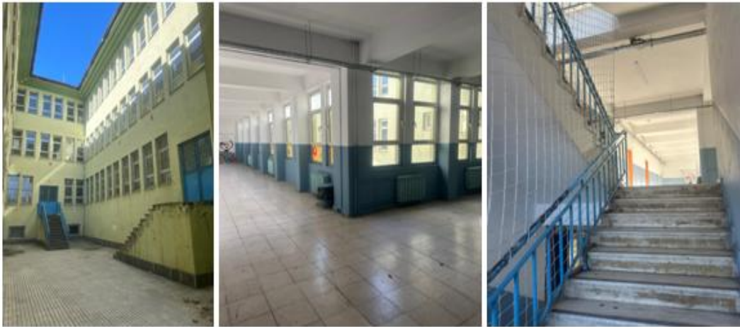
Şekil 29. Hasanpaşa Ortaokulu Dış ve İç Mekanlar
