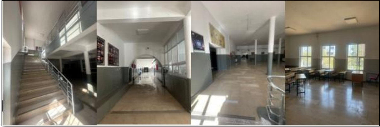
Şekil 18. Dağ Kapı İmam Hatip Ortaokulu İç Mekanlar
