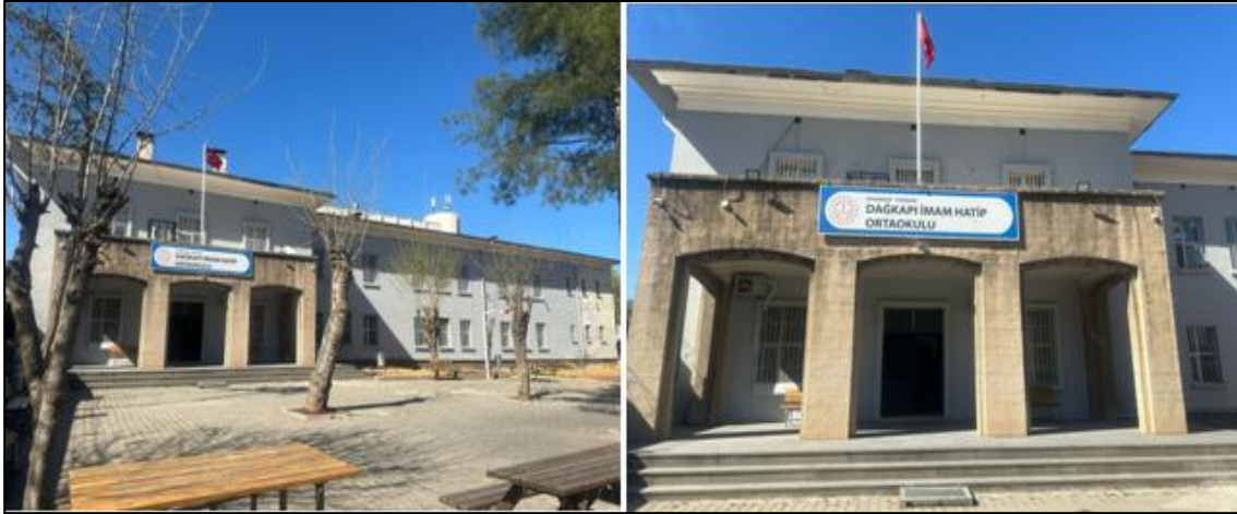
Şekil 17. Dağkapı İmam Hatip Ortaokulu Dış Cephe
