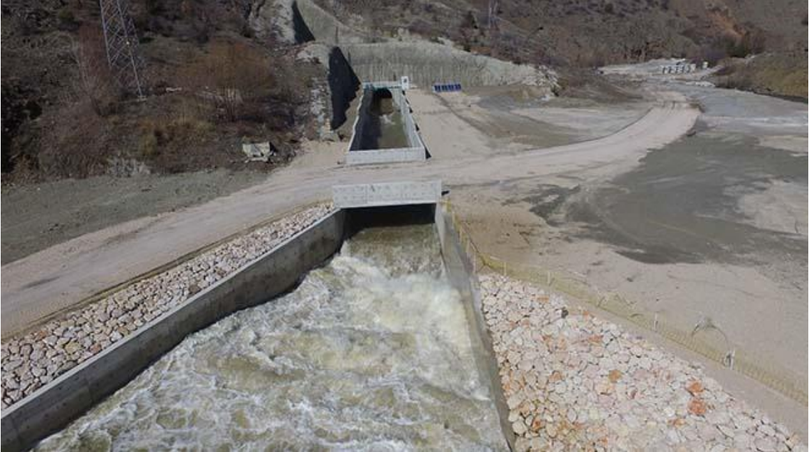
Şekil 5. Gerede Tüneli çıkışında Eşik Deresi'ne suyun boşalımı ( https://www.boluobjektif.com )
