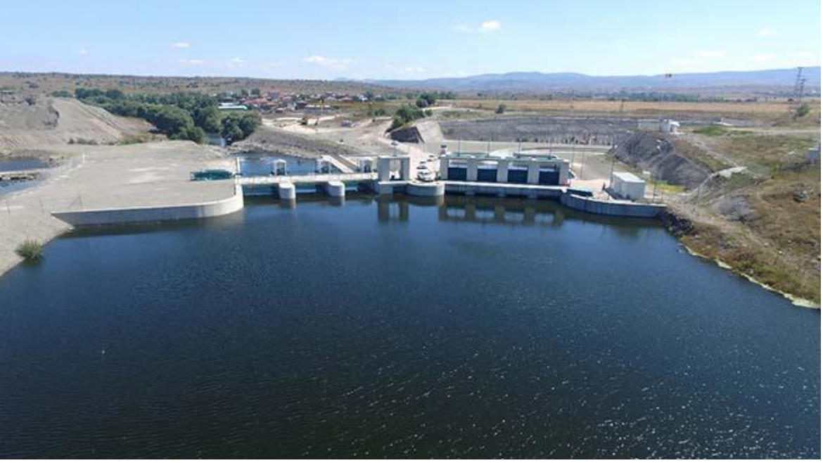
Şekil 4. Işıklı regülatörü ( https://www.google.com/search ): Sağ taraftaki dört gözlü su alma yapısından kanala alınan su tünele aktarılmaktadır.
