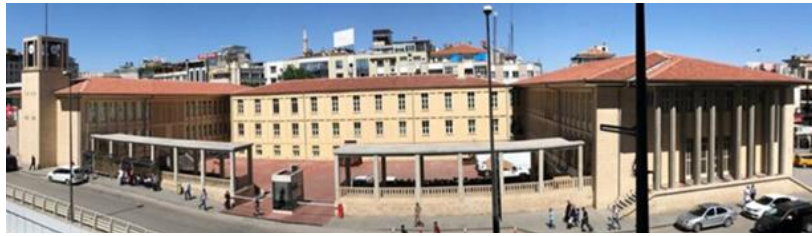
Görsel 19. Gaziantep Hükümet Konağı ön cephe (Sacır, 2018)
