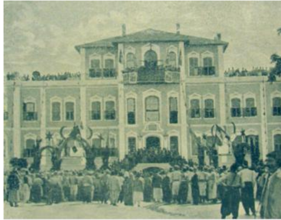
Görsel 4. Adana Hükümet Konağı (Umar, Can; 2019)
