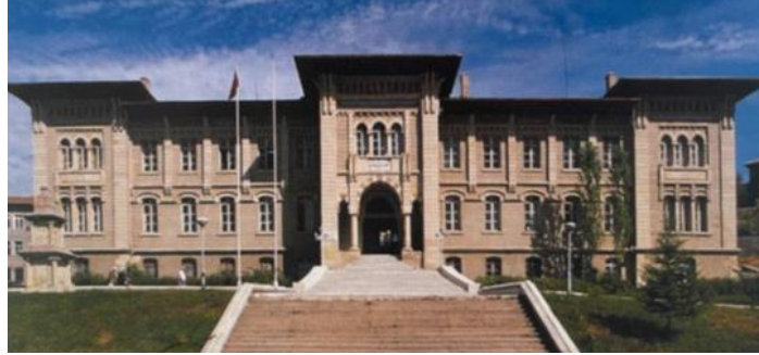
Görsel 6. Kastamonu Hükümet Konağı ön cephe (Balcı, 2022)
